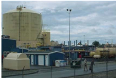
LNG Load-Out Facility
